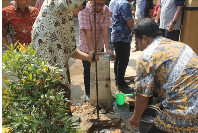
Gambar 9. Pemasangan elektroda batang
