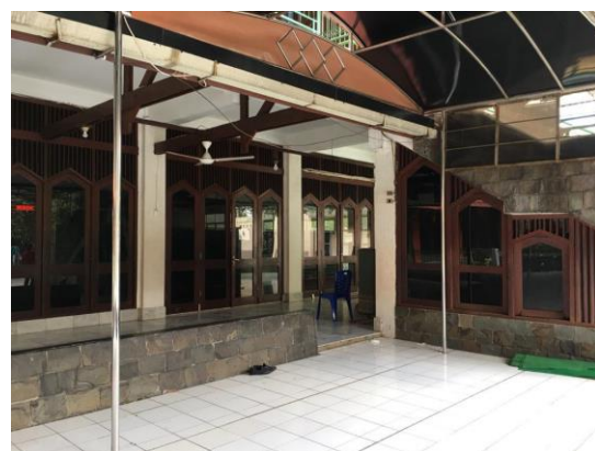
Gambar 4. Kusen Kayu Tetap Dipertahankan Pada Bagian Sisi Belakang Untuk Mengakomodir Konsep “Lama”
