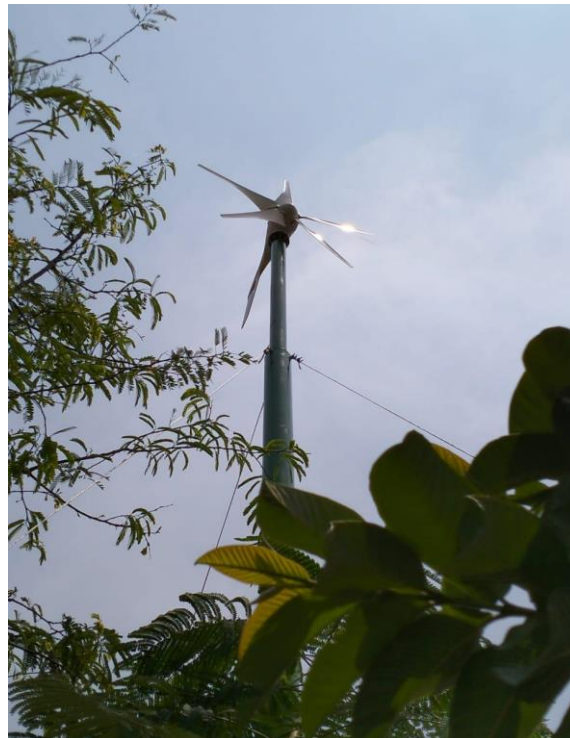
Gambar 4. Hasil pemasangan Wind Turbine.
