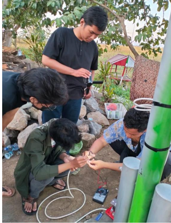
Gambar 3. Pemasangan Tiang dan Kabel Wind turbine.
