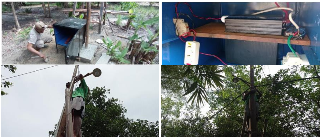
Gambar 5. Proses Instalasi Listrik dari Pembangkit Tenaga Angin
