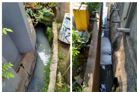
Gambar 5. Foto Saluran Air Limbah Permukiman
